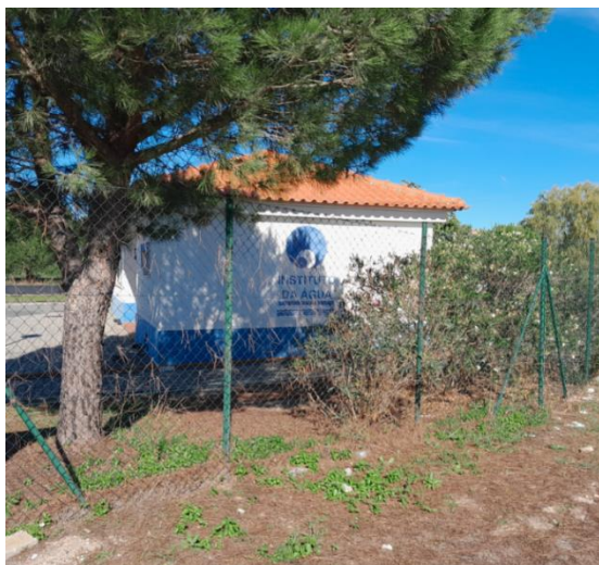
Figura 27- Edifício da Estação de Tratamento de Águas Residuais (ETAR) de Vale de Vargo (Arquivo pessoal).
