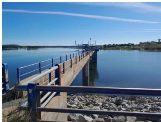
Figura 20- Albufeira de Enxoé (PT07GUA1522), torre de captação (Arquivo pessoal).
