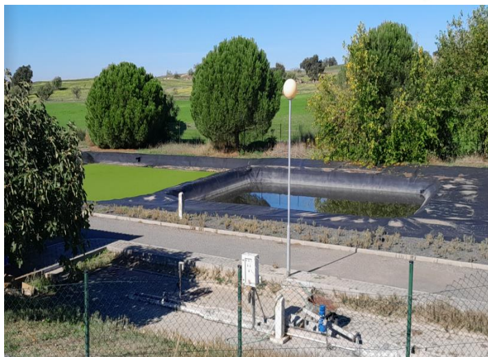
Figura 28- Lagoas da Estação de Tratamento de Águas Residuais (ETAR) de Vale de Vargo (Arquivo pessoal).
