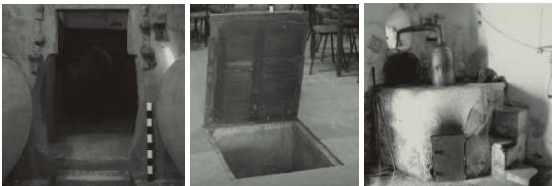
Figura 1-26- Particularidades das adegas de Vila Alva: porta com geometria adaptada à passagem de talhas- Adega do "Guel"; Dorna- Adega do Manuel Fernando; Alambique- Adega do João Carraça (Fonte: XXVI Talhas)
