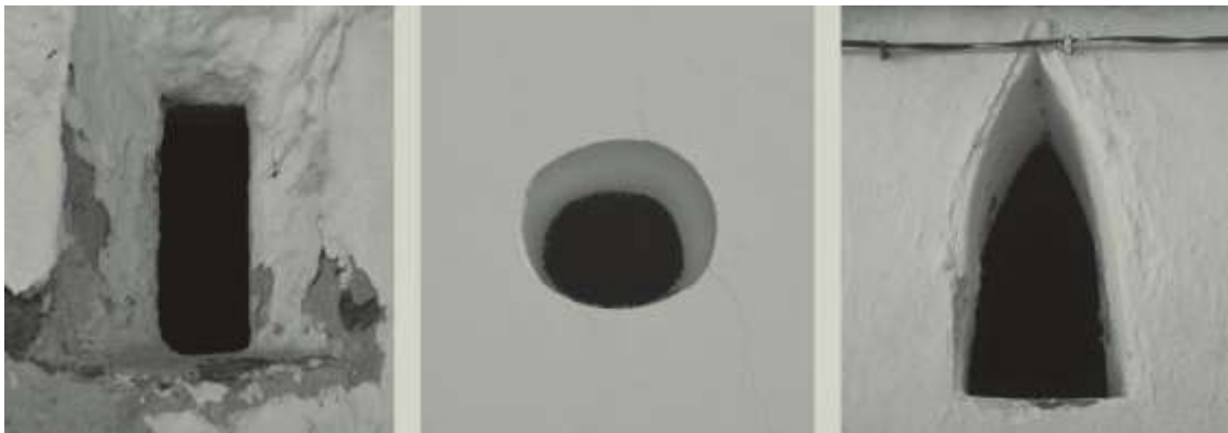
Figura 1-27- Aberturas retangular, circular e ogival em adegas de Vila Alva (Fonte: XXVI Talhas)
